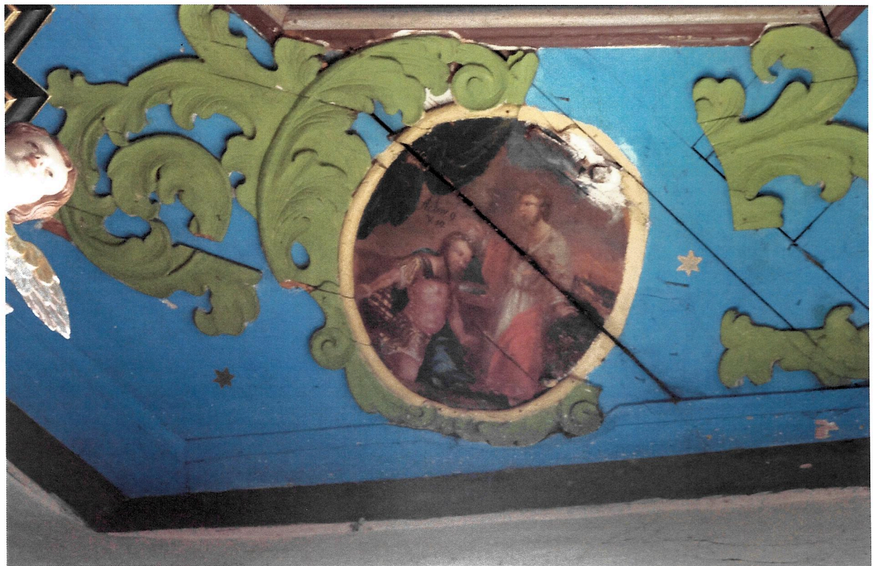
fot. 10 Kościół pw. Chrystusa Króla w Dłużycach, strop prezbiterium (II poł. XVII w.). Scena chrztu św. Pawła. Widoczne ubytki elementów snycerki i półwałków ramy; późniejsza polichromia deskowania i snycerki. Stan przed konserwacją. Fot. G. Wątor, 2021.
