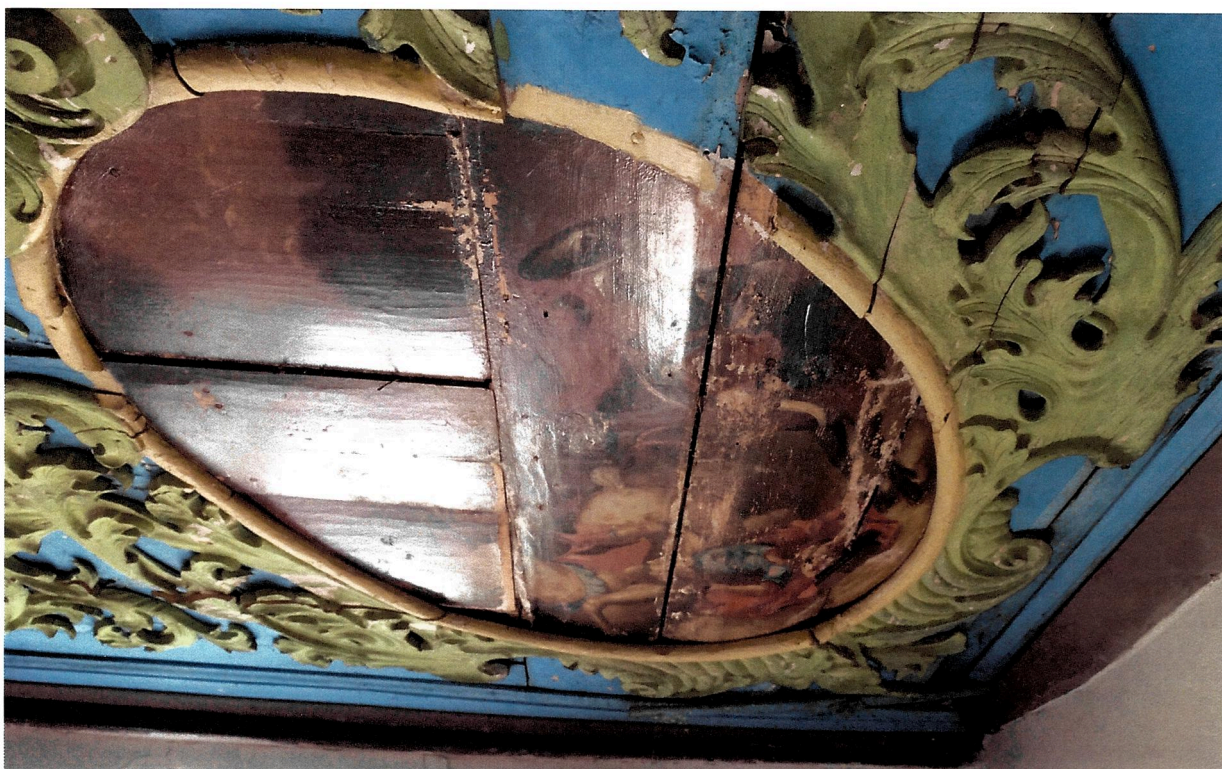
fot. 14 Kościół pw. Chrystusa Króla w Dłużycach, strop nawy (II poł. XVII w.). Scena nawrócenia się Szawła. Widoczne miejscowe łuszczenie się warstwy malarskiej i polichromii stropu. Stan przed konserwacją. Fot. G. Wątor, 2021.
