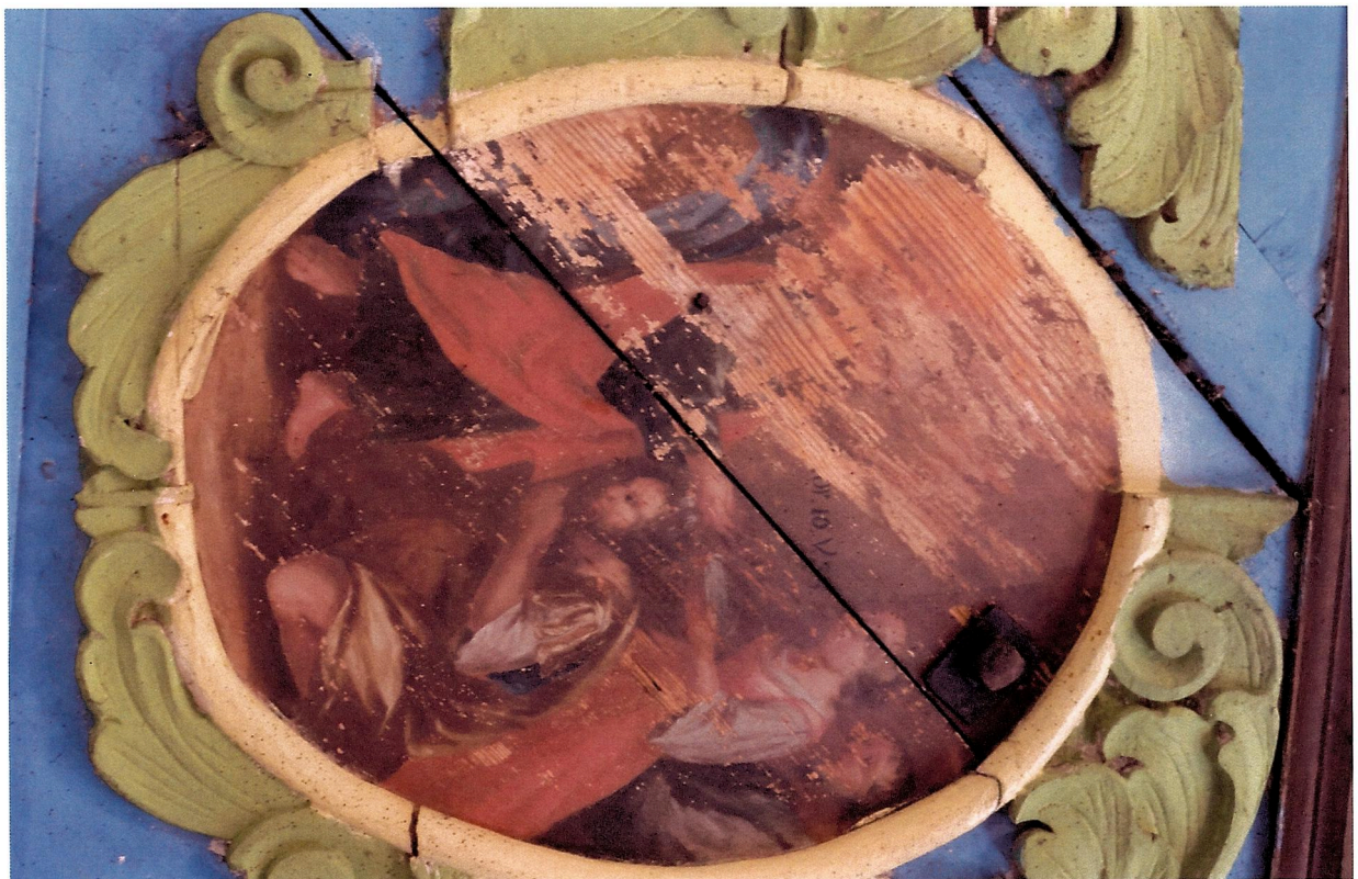
fot. 23 Kościół pw. Chrystusa Króla w Dłużycach, strop prezbiterium (II poł. XVII w.). Scena chrztu strażnika więziennego. Widoczne ubytki warstwy malarskiej i zaprawy, liczne otwory po drewnojadach; ubytki snycerki metalowe elementy mocujące desko- wanie. Stan przed konserwacją. Fot. G. Wątor, 2021.
