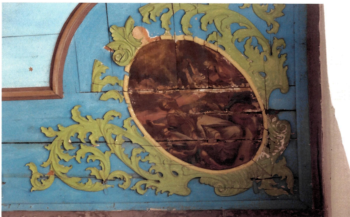
fot. 12 Kościół pw. Chrystusa Króla w Dłużycach, strop nawy (II poł. XVII w.). Scena ukamieniowania św. Szczepana. Widoczne ubytki drewna, brak pasów płótna na łączniu desek. Stan przed konserwacją. Fot. G. Wątor, 2021.
