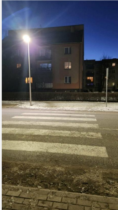
Przejście dla pieszych – ul. Wołowska w Ścinawie (zakończono, wartość inwestycji 62 114,63 zł)
