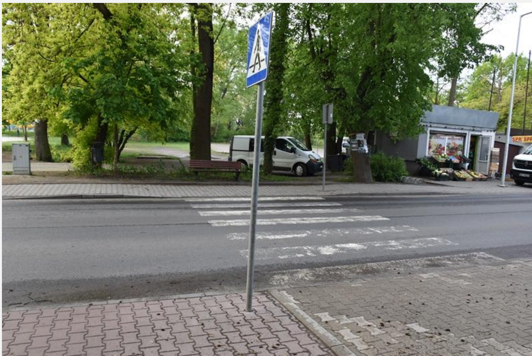
Przejście dla pieszych – ul. Jagiełły w Ścinawie (zakończono, wartość inwestycji 32 330,00 zł)
